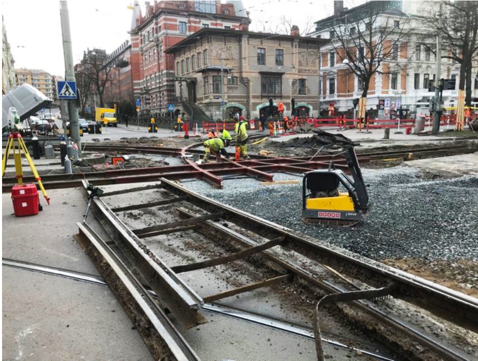
Spårarbete på Vasagatan, fotograf Jesper Olsson.
